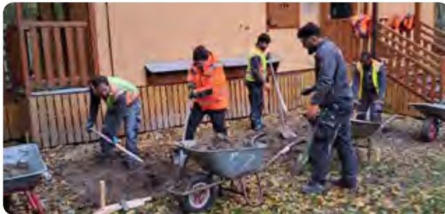
Algeco Dachs volunteering in Eitensheim.
