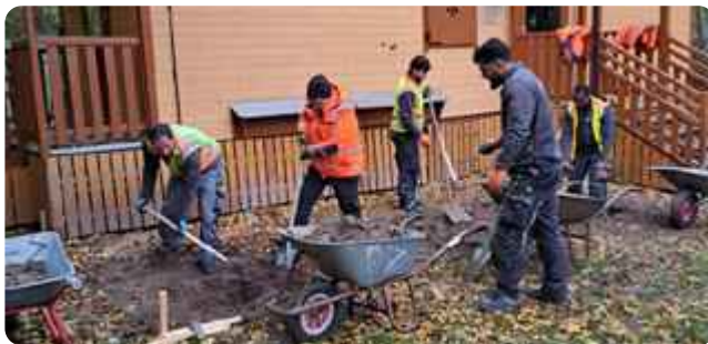
Algeco Dachs volunteering in Eitensheim.
